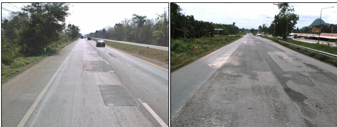
รูปที่ 1-123 ตัวอย่างสภาพผิวทาง 10 – 25 คะแนน Serious
