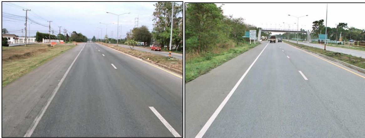
รูปที่ 1-128 ตัวอย่างสภาพผิวทาง 85 – 100 คะแนน Good
