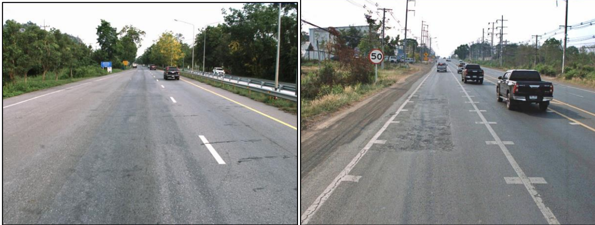
รูปที่ 1-124 ตัวอย่างสภาพผิวทาง 25 – 40 คะแนน Very Poor
