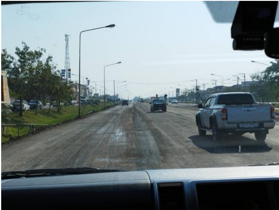
รูปที่ 2-1 อุปสรรคงานก่อสร้างถนนระหว่างการสำรวจ
