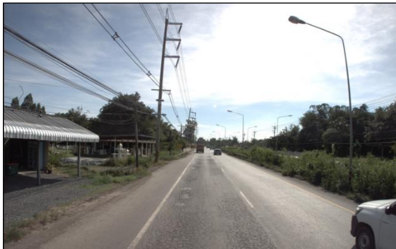
รูปที่ 1-38 พื้นที่ทดสอบที่ 2 ทางหลวงหมายเลข 33 ตอน 501
