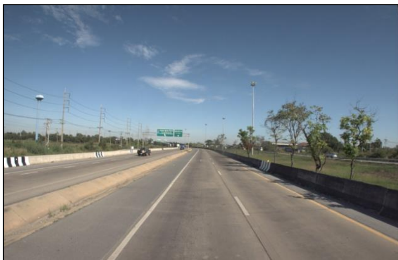
รูปที่ 1-39 พื้นที่ทดสอบที่ 3 ทางหลวงหมายเลข 347 ตอน 101 – 102
